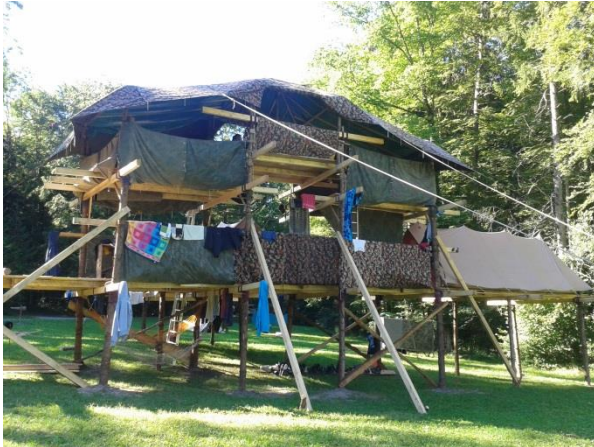
Der Leiterhochbau – Gute Führung ist bei dieser Übersicht garantiert.
